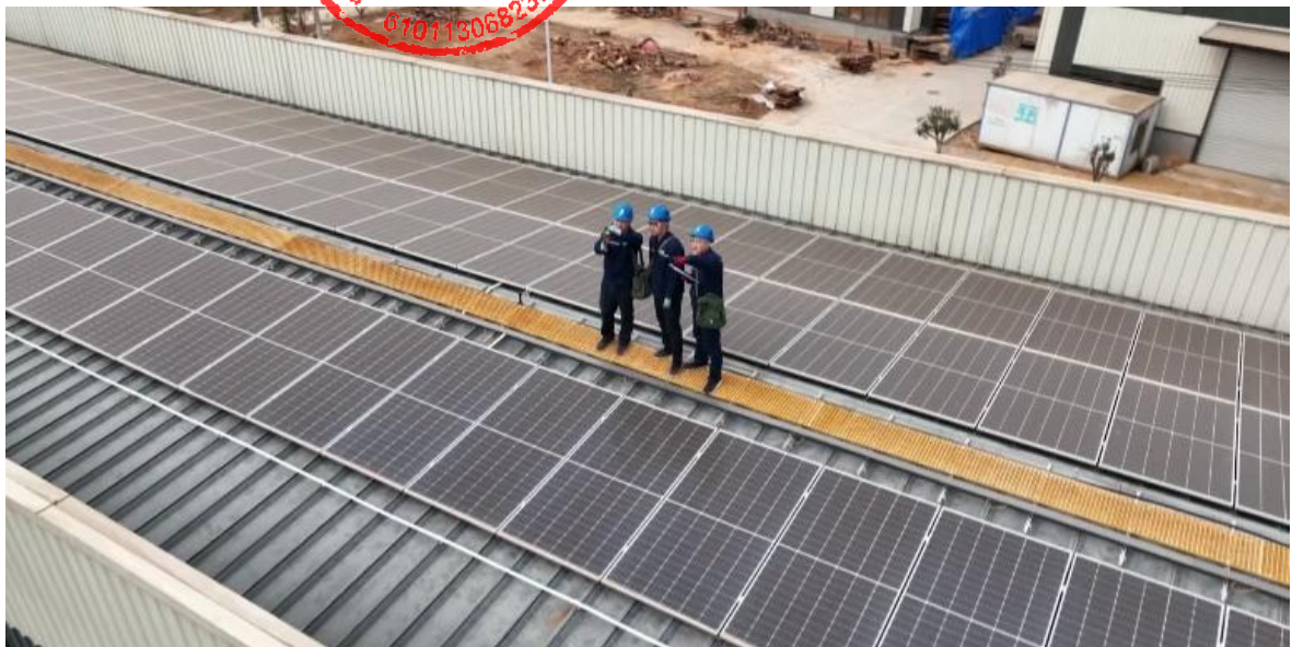
图5.5-1 彩钢瓦屋面固定安装方式布置图
