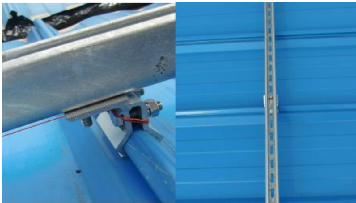
图7.3-1 夹具及铝合金轻型钢条形横梁方案照片
