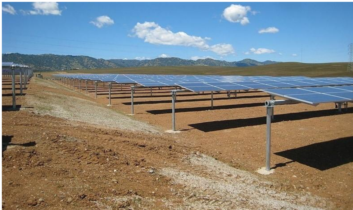
图5.5-2 水平单轴安装方式布置图
