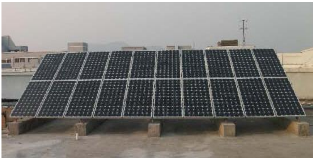
图 5.5-1 固定安装方式布置图
