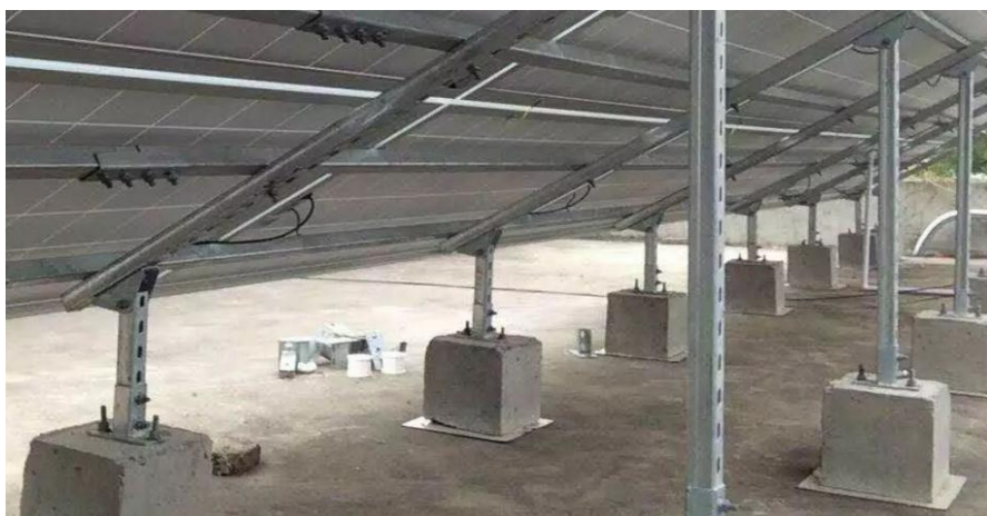
图 7.3-1 屋面板上设置砼支墩方案照片
